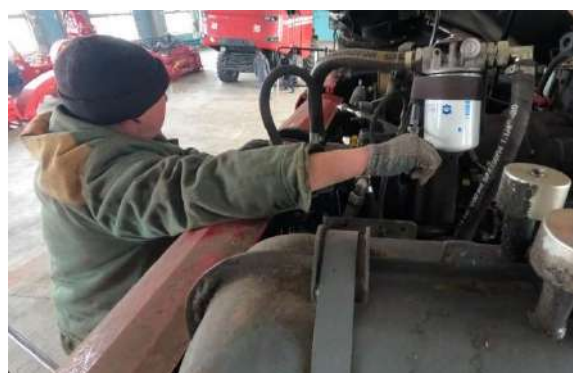
Рисунок 3.15 – Вид на демонтаж всасывающего фильтроэлемента с использованием ключа фильтра
